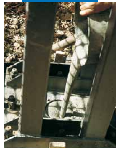
Закрепване на метално изделие с Mapefill E
